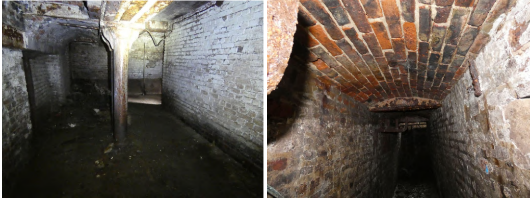
Caves du bâtiment K
