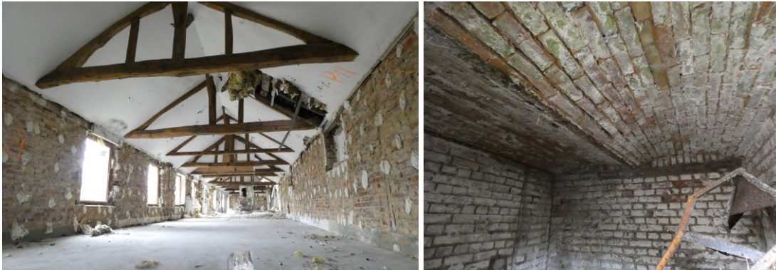
Dépendance 1 : rampants (gauche) et caves (droite)
